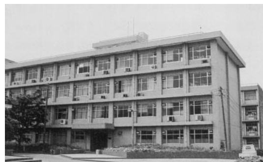
工学部応用化学工学科2号棟
